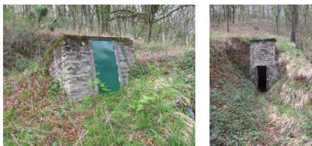
Figure 78 : Photographies du dépôt 12_0106_F_T1 (puits P5 à gauche et galerie G15 dite de « Saint-Joseph » à droite ; GEODERIS)
